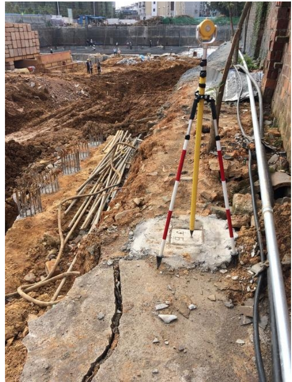
图 4 现场定期基坑监测和巡查
